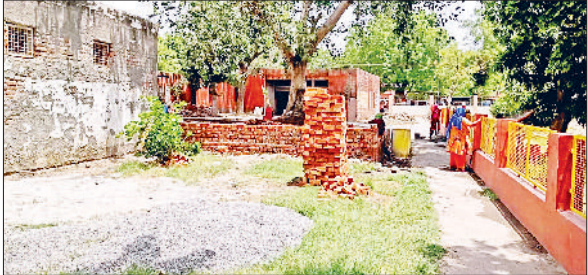
जींद। अमृत फार्मसी भवन के निर्माण में जुटे मजदूर।
